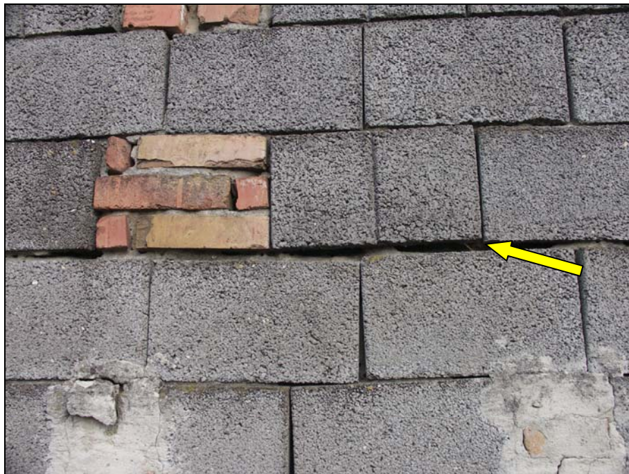
Abb. 7 Es müssen nicht immer typische Quartiere sein. Fledermäuse findet man an vielen Rohbauten, wo sie hinter kaputten Hohlblockziegeln oder auch in Spalten ihre Quartiere beziehen. Pfeil markiert das Quartier von Abendseglern ( Nyctalus noctula ). Foto: G. Reiter
