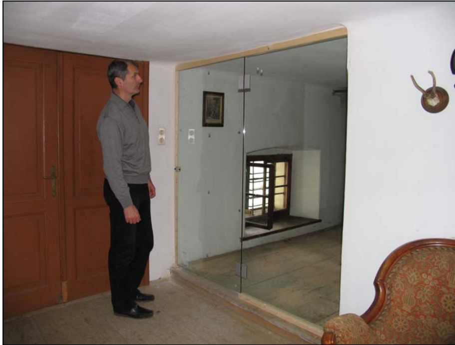
Abb. 10 Durch den Einbau von Glastüren konnte hier der Hangplatz der Kleinen Hufeisennasen vom Wohnraum räumlich getrennt und damit Konflikte vermieden werden. Foto: Schiegl/Arge NATURSCHUTZ.
